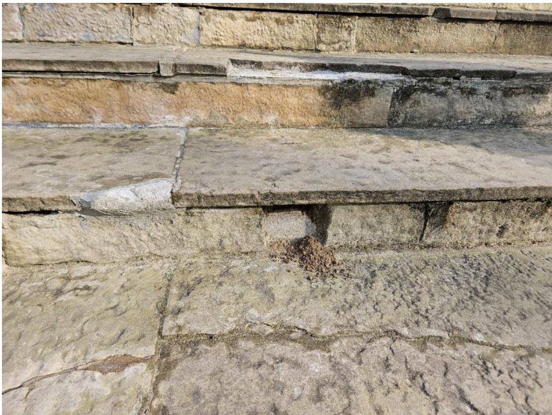
Zdj. 22 Uszkodzenia okładzin schodów nr 1
