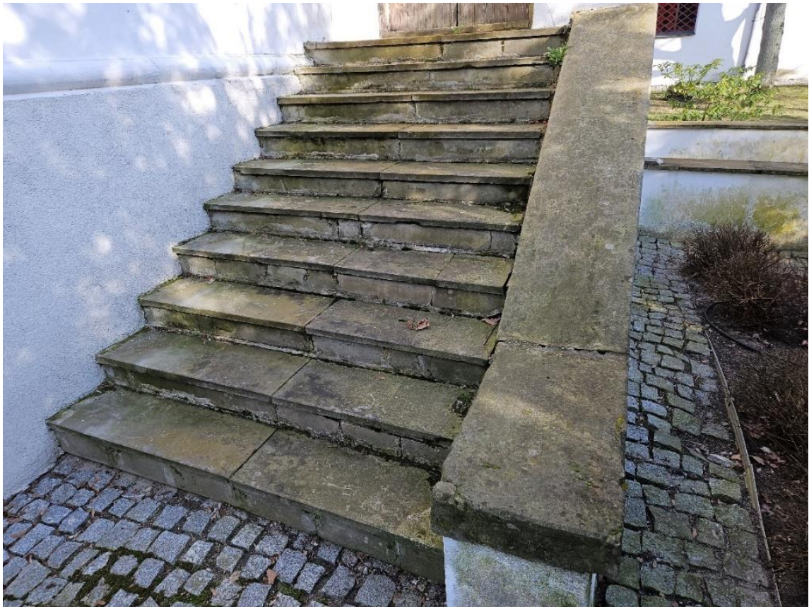
Zdj. 50 Schody nr 7 - uszkodzona okładzina schodów
