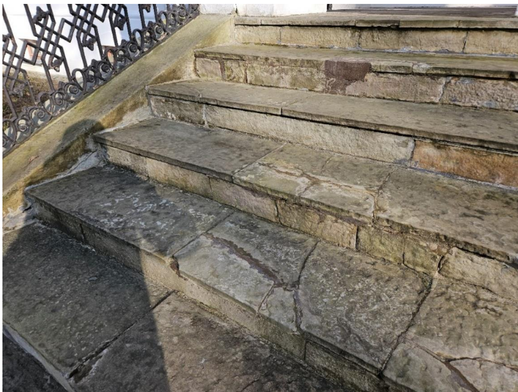
Zdj. 24 Uszkodzenia okładzin schodów nr 1
